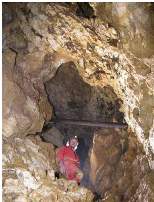
Fig. 6 - Beyond the staircase, a log is pinned between the walls and one side is stabilized with a terraced stone wall. The inverted stoping extraction (Fig. 2) allowed emptying a chimney from the bottom upwards (photo: J.-Y. Bigot). / Aldilà dei gradini, un tronco d'albero è incastrato tra le pareti ed una parte è stata stabilizzata con un muro di pietre terrazzate. L'estrazione per gradino inverso ripieno (Fig. 2) ha permesso di vuotare un camino dalla sua base verso l'alto (foto: J.-Y. Bigot).
